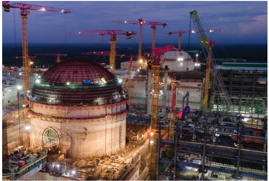
Nhà máy điện hạt nhân Rooppur, Bangladesh (Ảnh: JSC Atomstroyexport)
